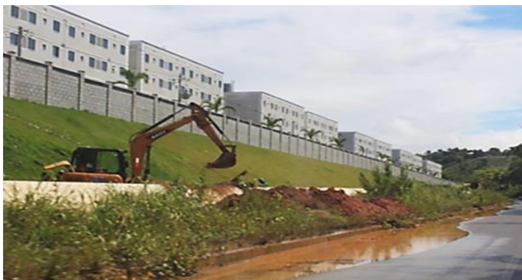
Figura 17: Construção de condomínio no território do Quilombo do Quingoma
