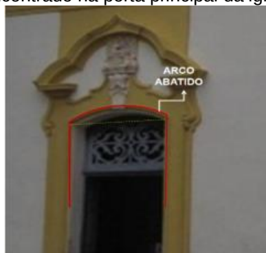
Imagem 15: Arco rebaixado encontrado na porta principal da igreja de São João Batista
