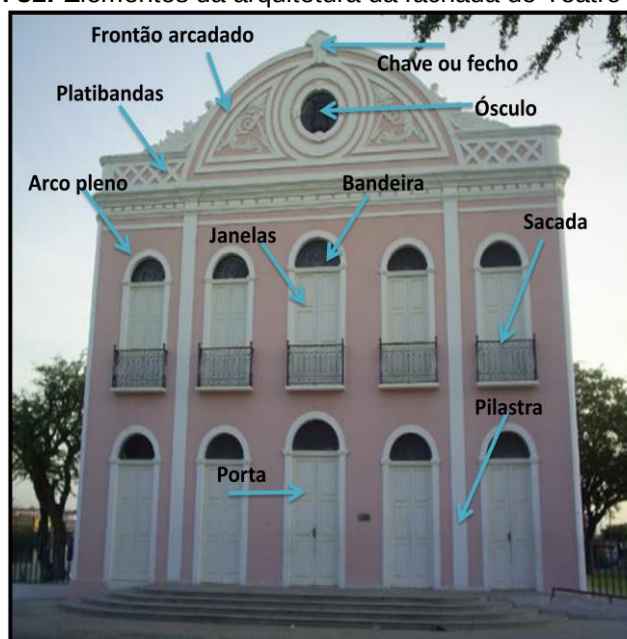
Imagem 31: Elementos da arquitetura da fachada do Teatro São João
