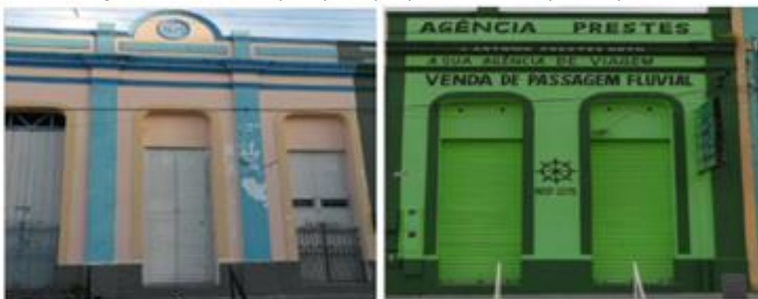
Imagem 23: Residência (à esquerda) e ponto comercial (à direita) de 1937
