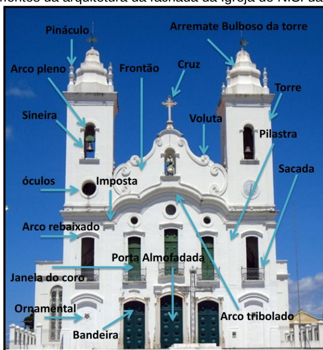
Imagem 29: Elementos da arquitetura da fachada da Igreja de N.S. da Conceição
