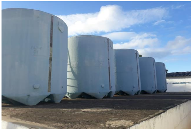
Figura 3: Filtros em fibra de vidro. Fonte: Moreira, 2020.
