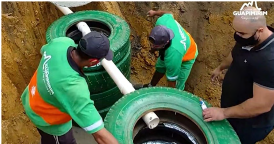
Figura 13: Fossa, filtro e sumidouro com pneus.
