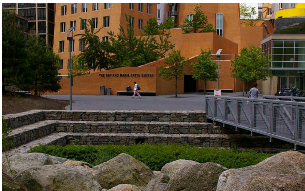
Figura 6: Exemplo de bacia de infiltração localizado no MIT, Estados Unidos.
