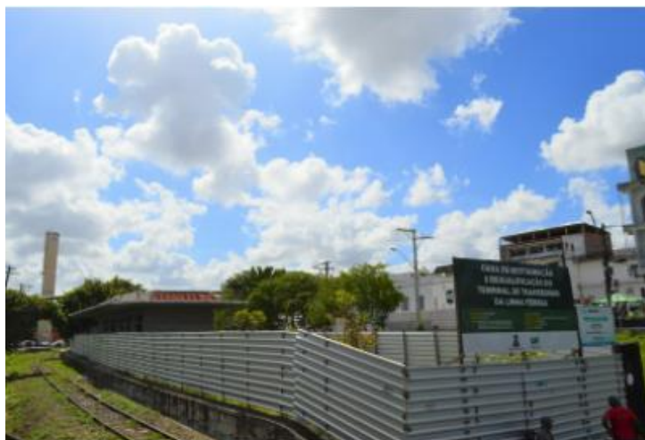
Figura 16 – Reforma da estação ferroviária - 2021
