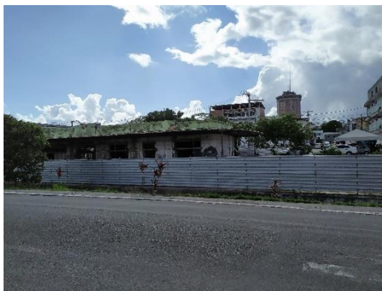
Figura 7 – Estação de trem em reforma
