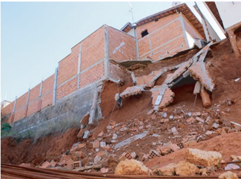
Figura 7 – Imóvel no talude de escavação
