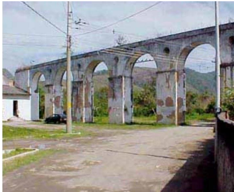
Figura 1- Aqueduto dos psicopatas.
