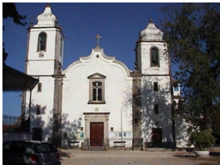
[Figura 2] Fachada principal orientada a sudoeste. Fotografia de Olívia da Costa.
