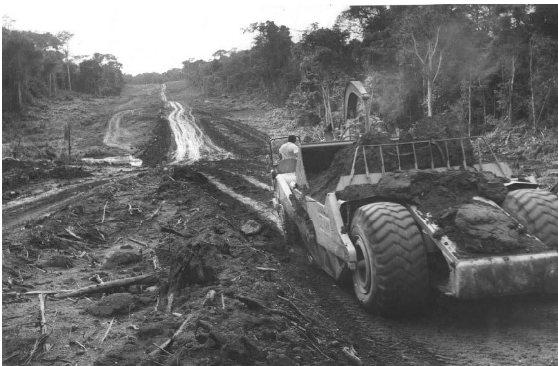
Figura 10 - Construção da rodovia BR-230, a Transamazônica
