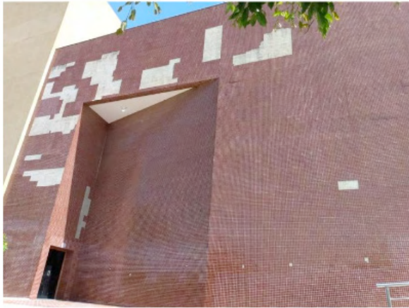
Figura 2-Destacamento das pastilhas cerâmicas. Fachada lateral esquerda.
