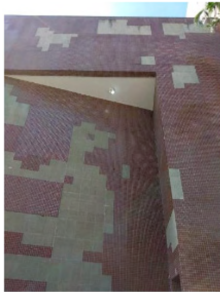
Figura 3-Descolamento. Fachada lateral direita.
