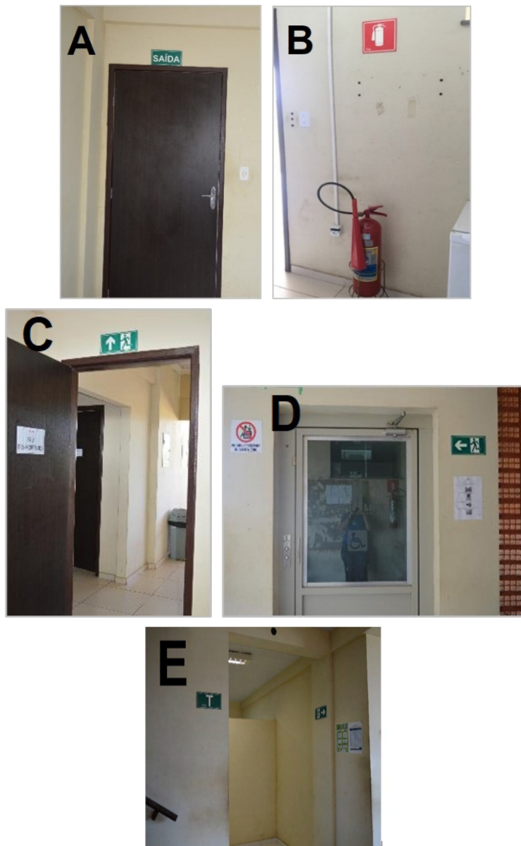
Figura 7: Pós instalação das medidas de segurança no Prédio de Física. A: Placa de saída (S12); B: Placa de extintor (E5); C: Placa de siga (S3); D: Placa de proibido usar o elevador (P4) e Saída à esquerda (S1). E: Placa de identificação do andar (S17) e Saída à direita (S2).
