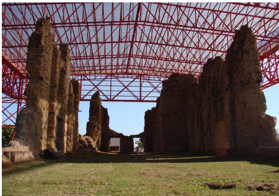
Figura 25- Ruínas da Igreja Matriz de Vila Bela da Santíssima Trindade Fonte: acervo do Autor
