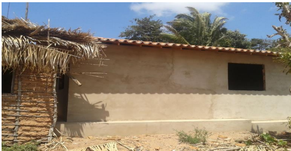
Foto 03: casa camponesa padrão ao lado de unidade do PNHR, em construção: Fonte: Deuzilene Viegas-Aragão, 2015
