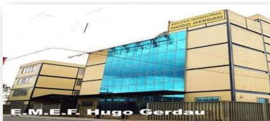
FIGURA 3: FACHADA EXTERNA DA ESCOLA:
