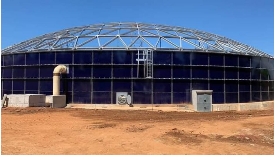
Foto 1 – Obras para a ampliação de reservação de água
