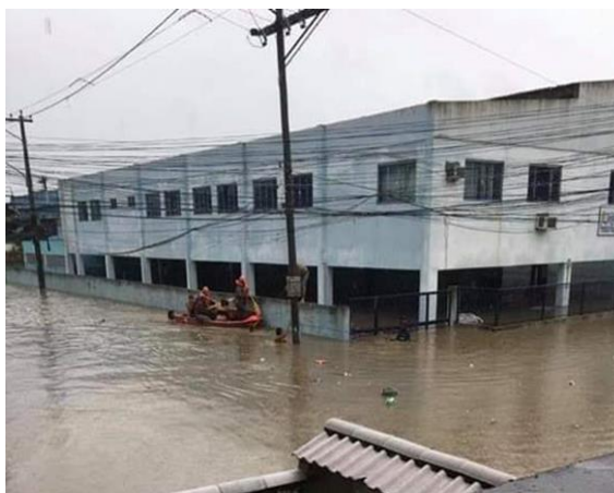
Figura 1 – Prédio novo da escola visto de lado em dias de enchente
