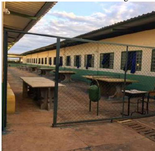
Figura 3: Bloco de salas de aula do CEF Miguel Arcanjo. 2019.
