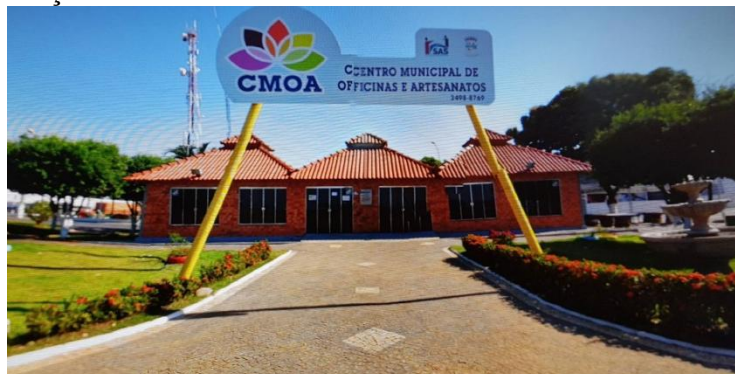
Figura 17 – Instalação do CMOA
