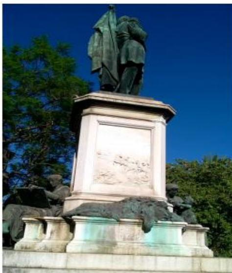
Figura 5. Estátua em liga de cobre apresentando pátinas verdes e pretas.
