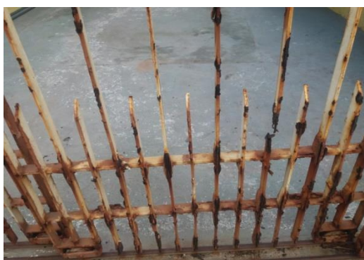
Figura 1. Corrosão metálica em portão
