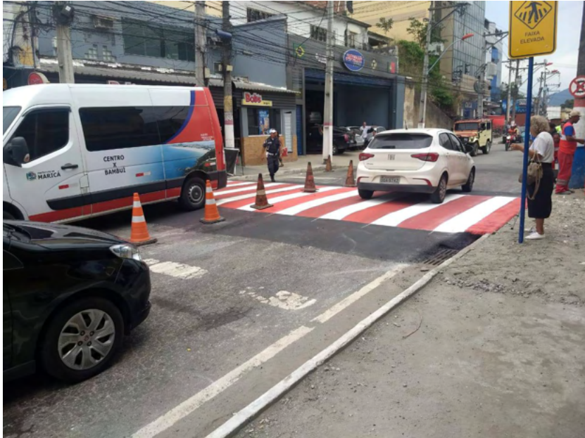
Figura 3: Medidas moderadoras de tráfego - calçada contínua, faixa de pedestre elevada, sinalização e outras.
