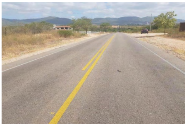
Figura 4: Extensão da via sem a presença de defeitos no Trecho 1.
