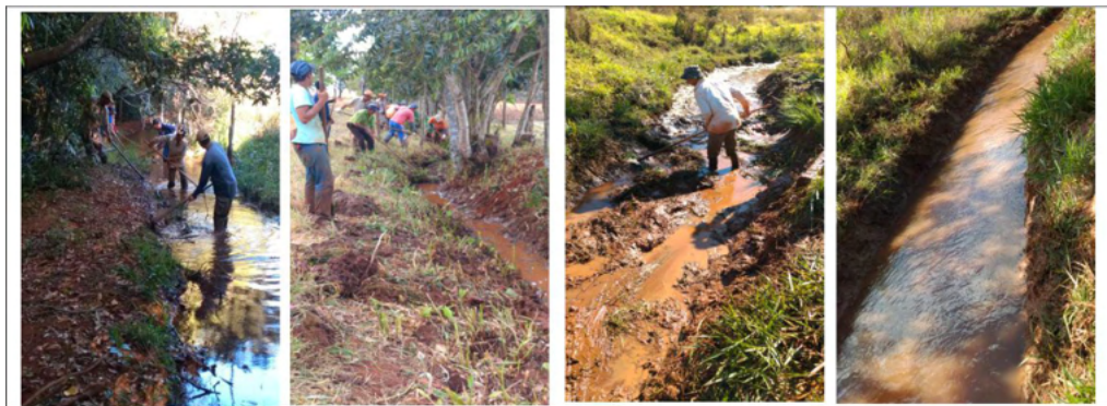
Figura 5 – Limpeza do rego d'água - situação antes e depois da limpeza
