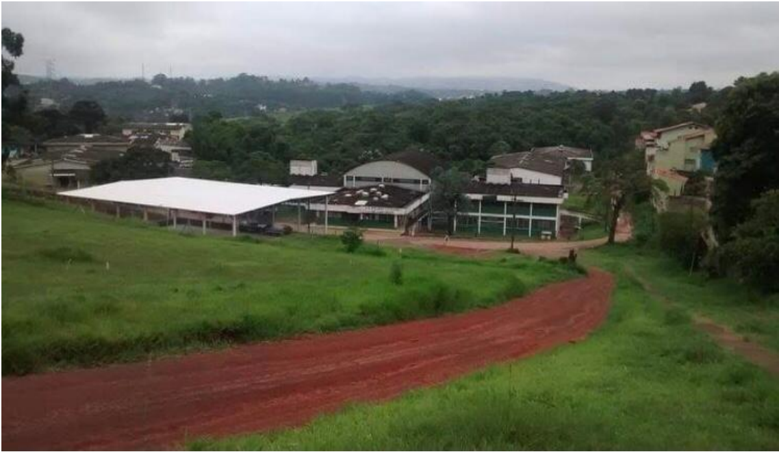
Figura 33 – Terreno onde ficava a Escola Cotolengo
