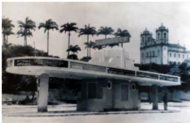
Fig. 8: Abrigo do Bonfim, na época em que funcionaram os bondes, Salvador, s/d.
