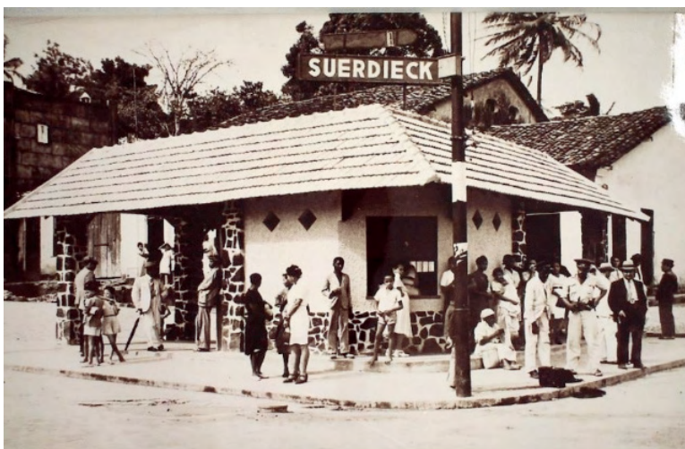
Fig. 18: Um dos abrigos executados pela Empresa Bahiana de Publicidade, cujo local de construção não foi possível identificar, s/d.
