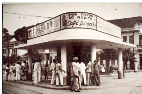
Fig. 16: Abrigo do Largo das 7 Portas, Salvador, s/d.
