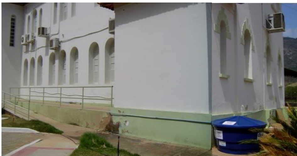
Figura 4. Instalação para captação de água de aparelhos de ar condicionado implantado no Instituto Federal do Espírito Santo (2016)
