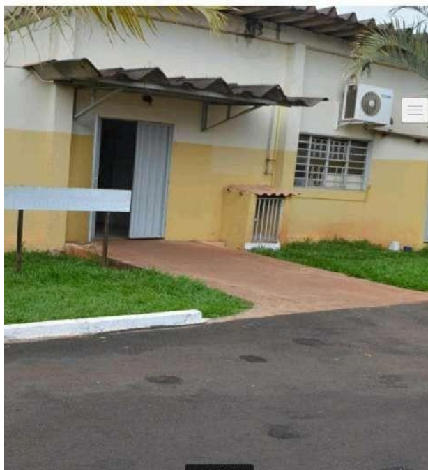
Figura 12 - Bloco de Salas de aula no pavilhão de engenharia de alimentos, com rampas
