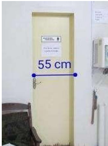
Figura 2 - Largura da porta do banheiro da coordenação PPGA
