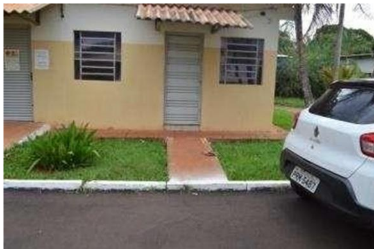
Figura 5 - Bloco de Salas de aula no pavilhão de engenharia de alimentos, sem rampas
