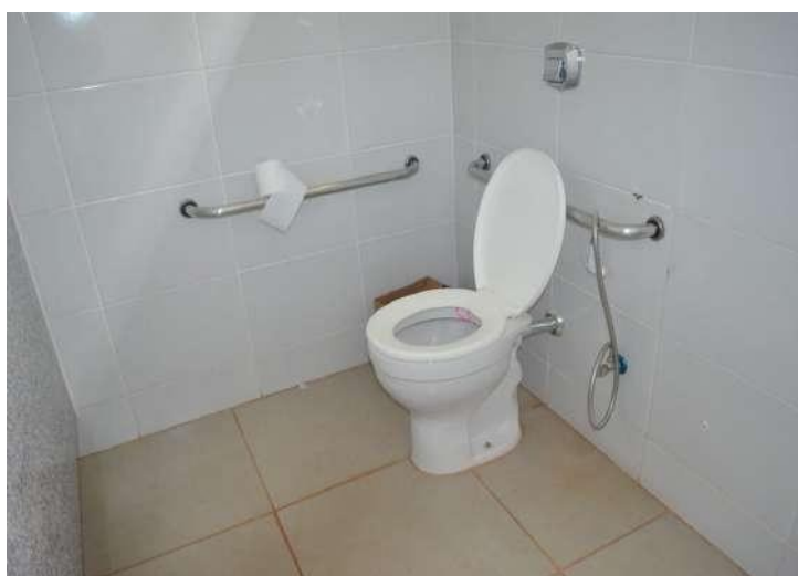
Figura 16 - Bloco 3 de salas de aulas – Banheiro Adaptado
