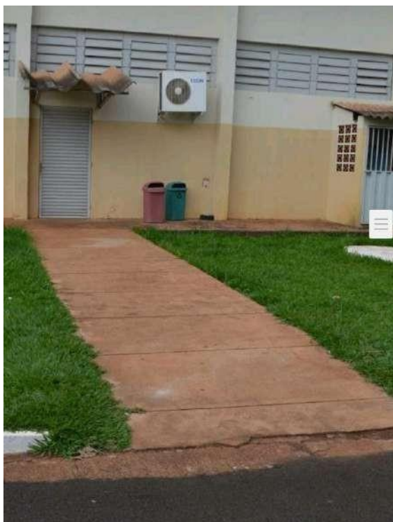
Figura 11 - Bloco de Salas de aula no pavilhão de engenharia de alimentos, com rampas
