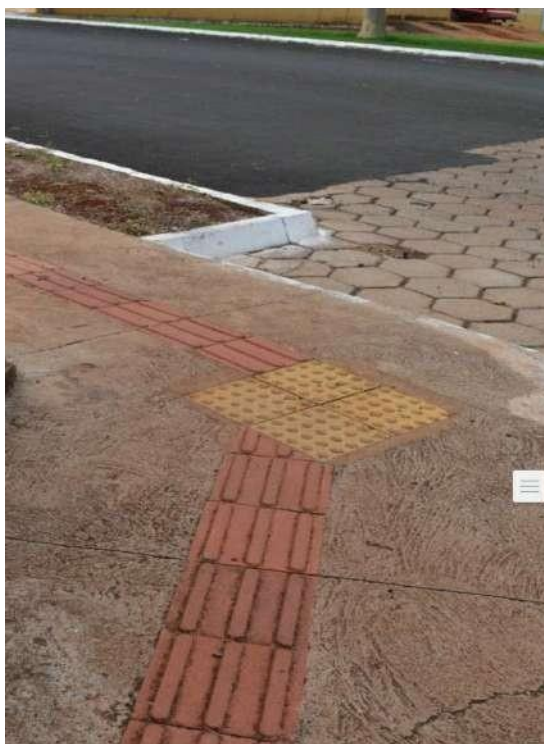
Figura 14 - Virada nos blocos de engenharia, piso tátil
