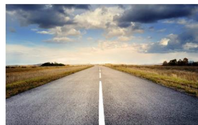
Figura 1. Estrada revestida com massa asfáltica.
