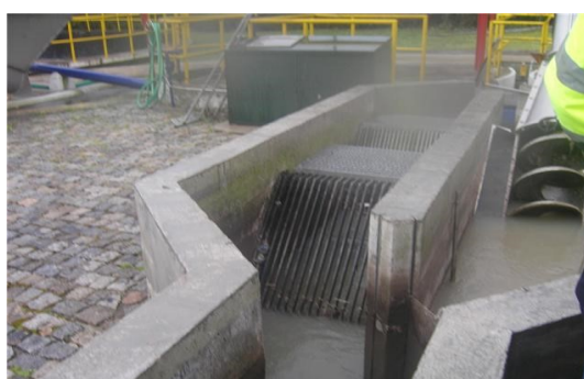
Figura 2.8 – Gradagem manual
