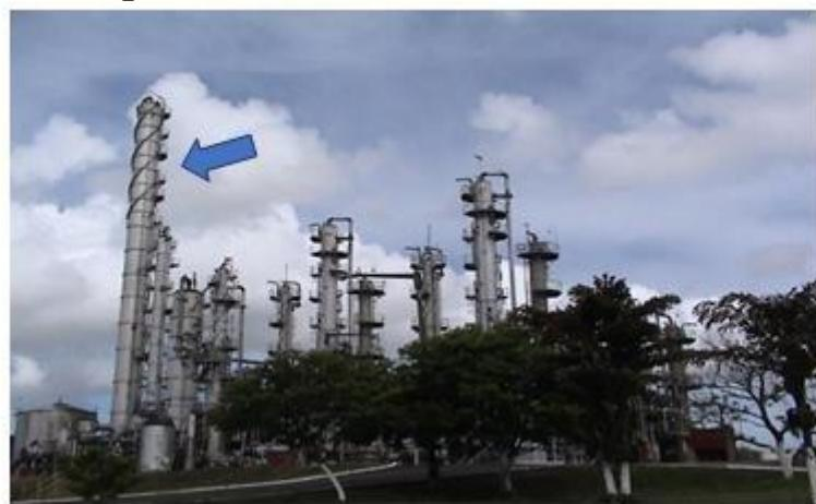
Coluna de purificação do acetato de vinila. No fundo desta coluna, concentrava m-se os subprodutos acetato de etila e butila.
