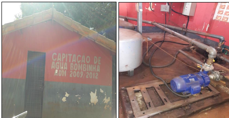
Figura 23 - Captação do poço raso – Bombinha
