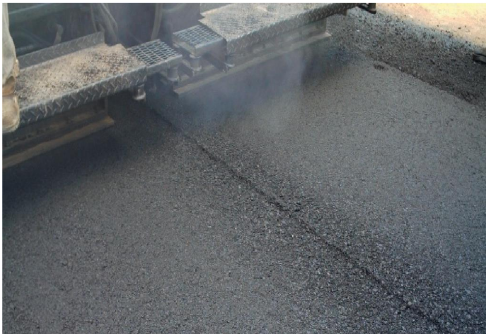
Figura 1 – Vantagem do uso do asfalto-borracha com aproveitamento de pneus usados
