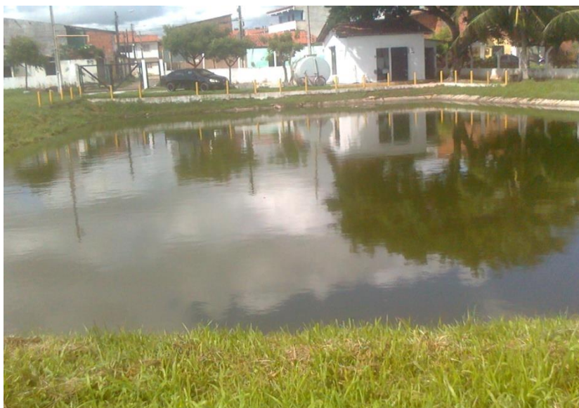
Figura 20 - Lagoa anaeróbia da ETE Guadalajara
