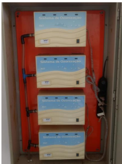
Figura 37 - Sistema de ozonização RXT da ETR Guadalajara
