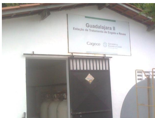
Figura 48 - Estado da pintura da ETER Guadalajara
