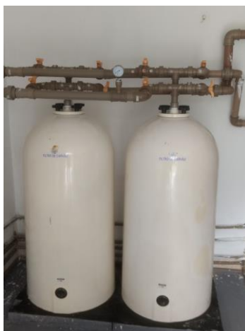
Figura 39 - Filtros de carvão usados na ETR Guadalajara
