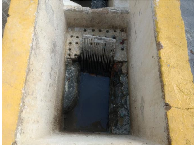
Figura 17 - Gradeamento da ETE Guadalajara
