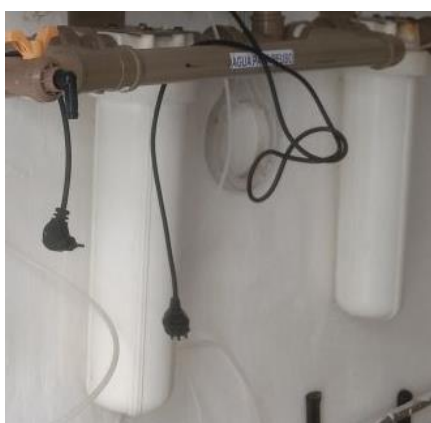
Figura 40 - Filtros de Propileno usados na ETR Guadalajara
