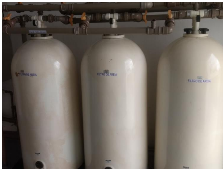
Figura 36 - Filtros de areia utilizados na ETR Guadalajara
