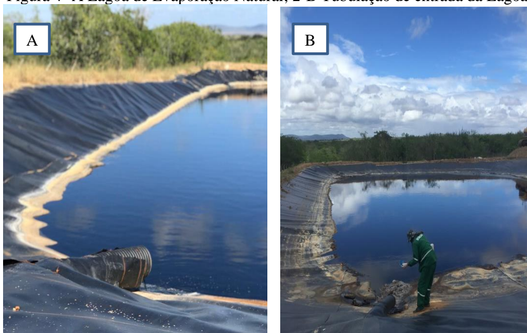
Figura 4- A Lagoa de Evaporação Natural; 2-B Tubulação de entrada da Lagoa
