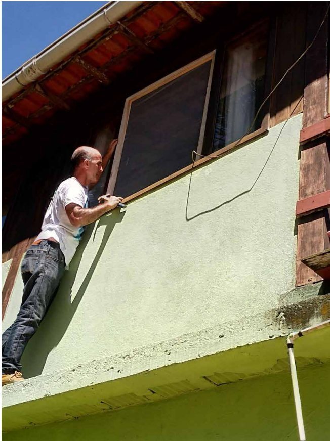
Figuras 2 e 3 – Instalação das Telas Impregnadas.
