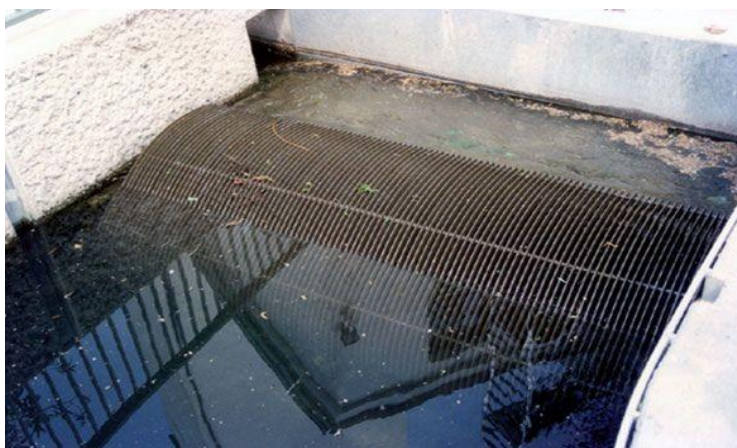
Figura 25 - Peneira precedendo um reator UASB
