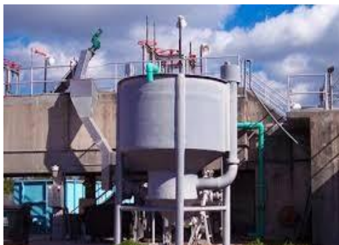
Figura 17 - Desarenador de Fluxo em Vórtice.
