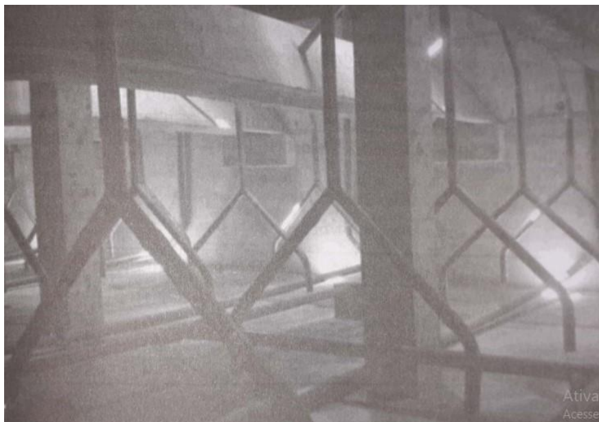
Figura 27 - Alimentação interna -UASB
