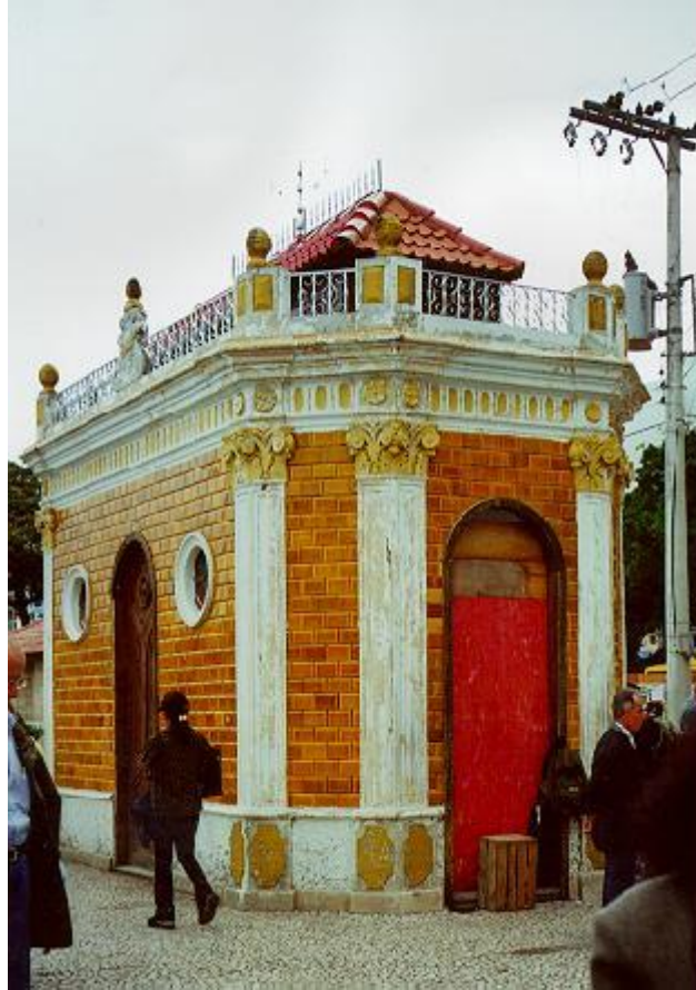
Estação de Elevação Mecânica - Museu do Saneamento, tombado pelo Decreto nº 31.255 de 31 de dezembro de 1986.
