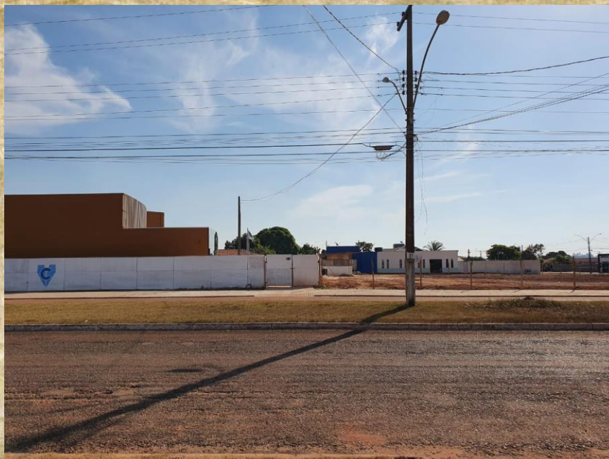
(Foto da construção da nova sede da Prefeitura)
