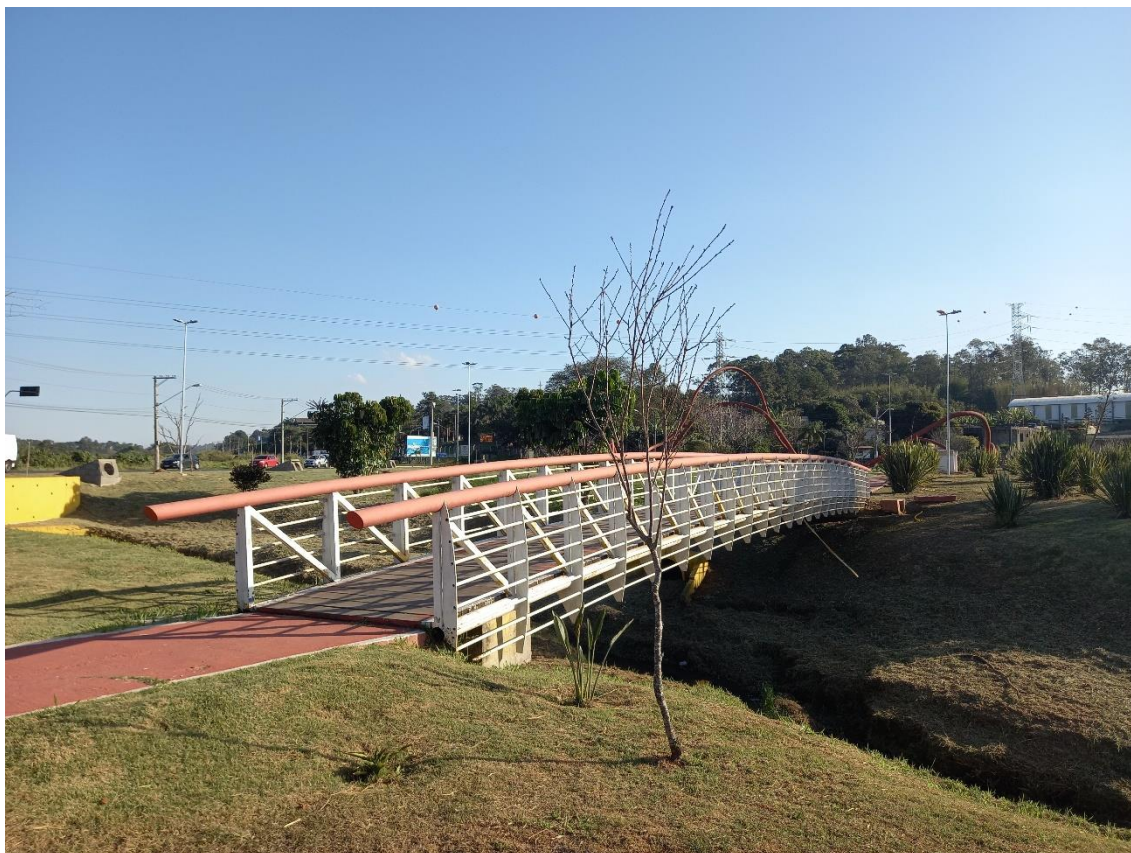
Figura 37 - Ponte arcada na Praça do Sol Nascente. Foto registrada em: 05/07/2020. Fonte: Arquivo pessoal | Foto: Douglas Santos.
