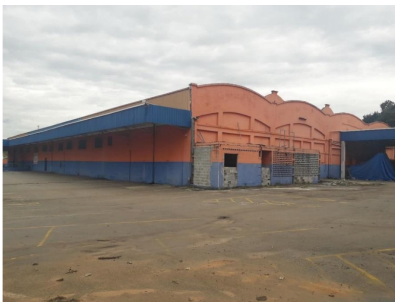
Figura 22 - Antiga fábrica de vinhos Irmãos Raffo. Foto registrada em: 17/05/2020. Foto registrada em: 10/12/2019. Fonte: Arquivo pessoal | Foto: Douglas Santos.
