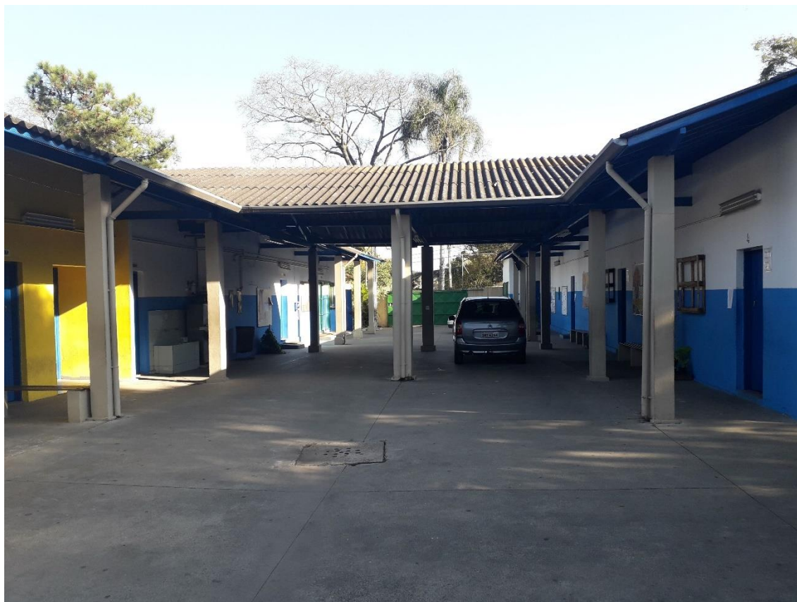
Figura 25 - Pátio interno da escola. Foto registrada em: 08/05/2020. Fonte: Arquivo pessoal | Foto: Douglas Santos.
