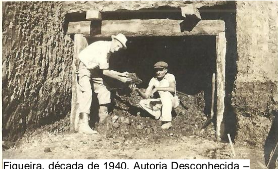
. Emboque Inicial de Galeria
