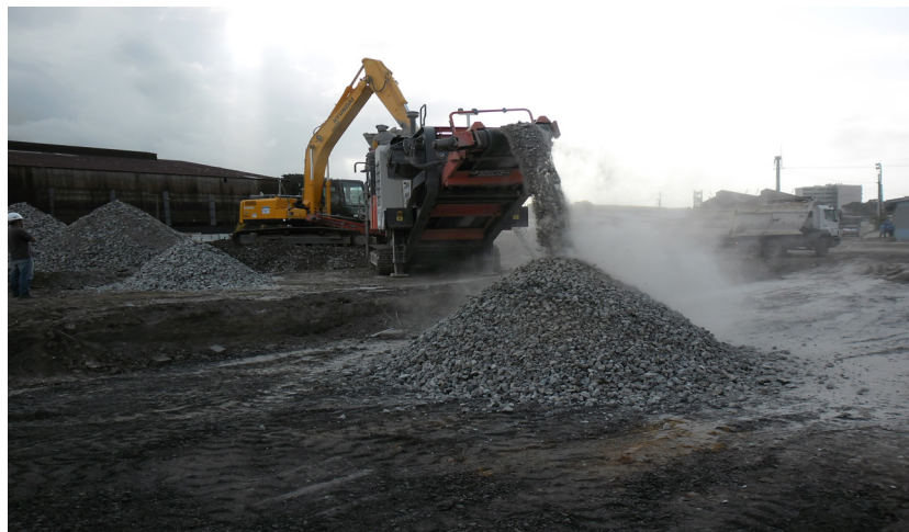
Figura 1 - Ilustração da britagem do RCC no britador móvel dentro do canteiro de obras.
