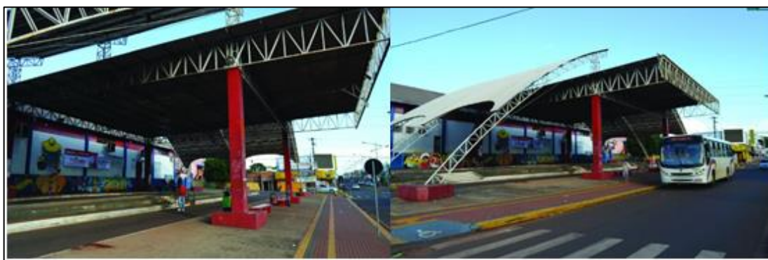
Figura 4: Terminal Vila Pioneiro
