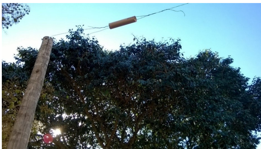
Figura 4: Isolamento do fio da antena com pedaço de cano de PVC. Fonte: o autor.
