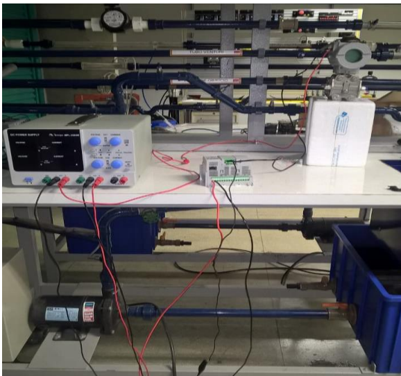
Figura 6 - Teste com CLP e transmissor.
