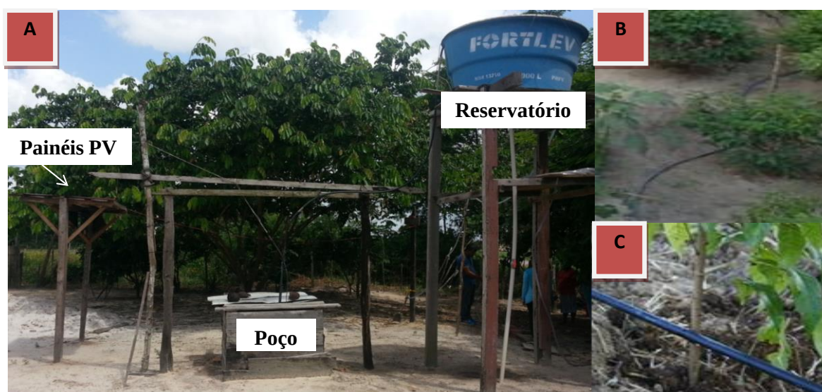
Figura 04 – (A) Sistema fotovoltaico de bombeamento para irrigação; (B) Distribuição de água aplicada com mangueiras perfuradas; (C) Mangueira para Irrigação.
