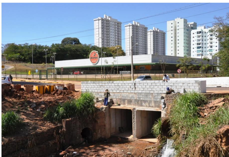
Figura 14 – Área da construção do Hipermercado (SEMMA, 2017)
