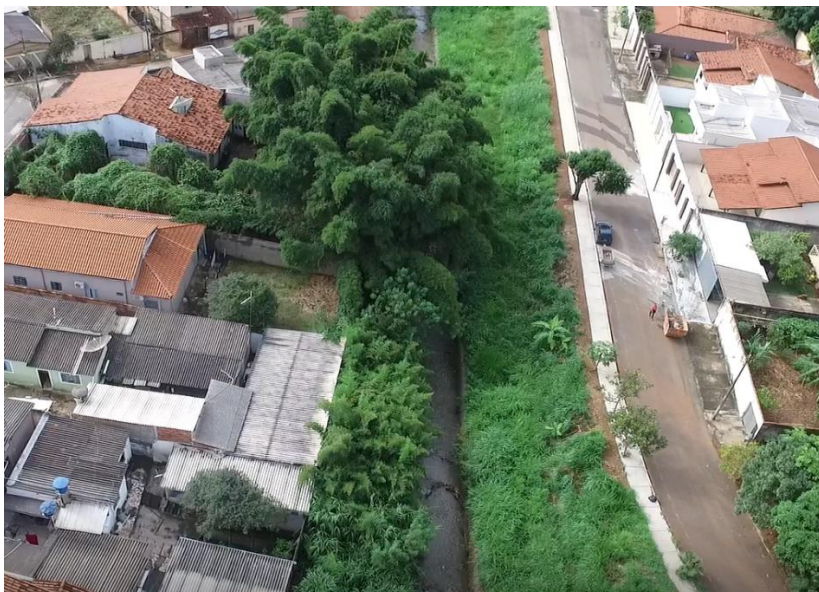
Figura 11 – Gabiões implantados para contenção das erosões e recuperação da mata ciliar.
