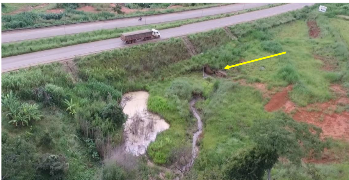
Figura 07 - Nascente e trecho de passagem por baixo da BR 153.
