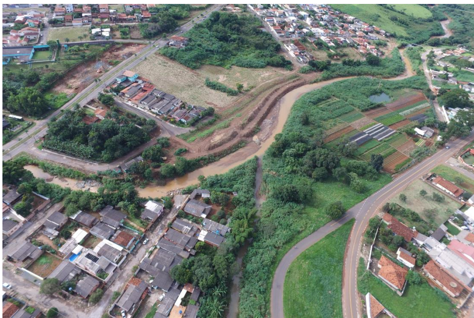
Figura 12 – Ocupações irregulares e processos erosivos.
