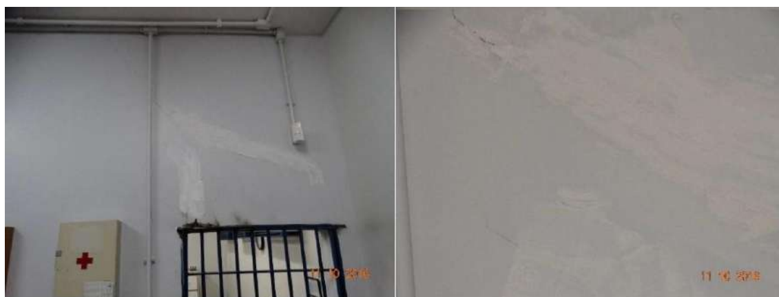
Figura 17 – Monitoramento da rachadura na alvenaria externa acima da porta de acesso do cofre, aparentemente não ativa.
