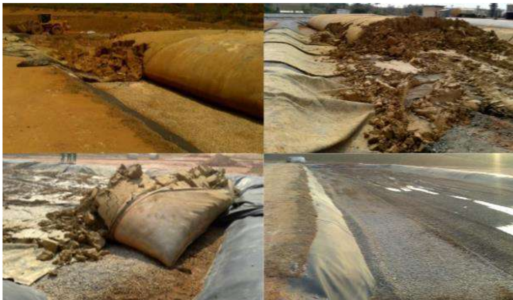
Figura 01: Lodo de chorume coletado em geobag, in loco.
