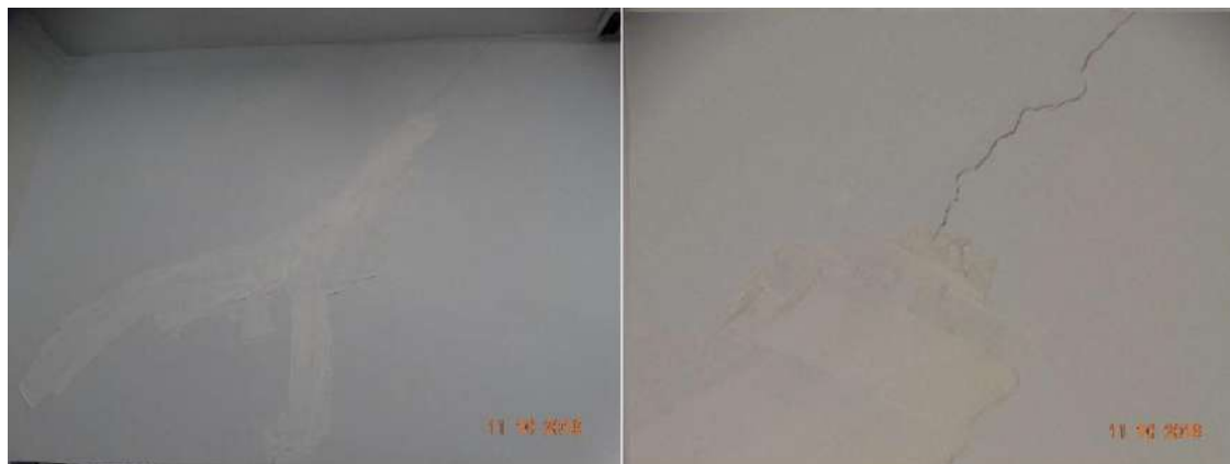
Figura 18 – Monitoramento da trinca na alvenaria interna acima da porta de acesso do cofre, aparentemente não ativa.
