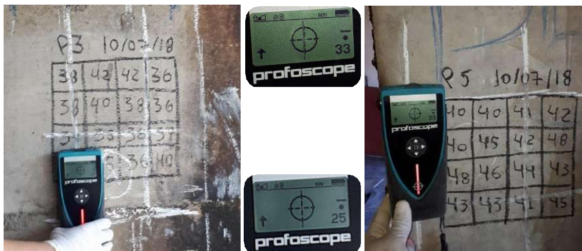
Figura 12: Determinação do posicionamento das armaduras e espessura do cobrimento de concreto utilizando pacômetro.
