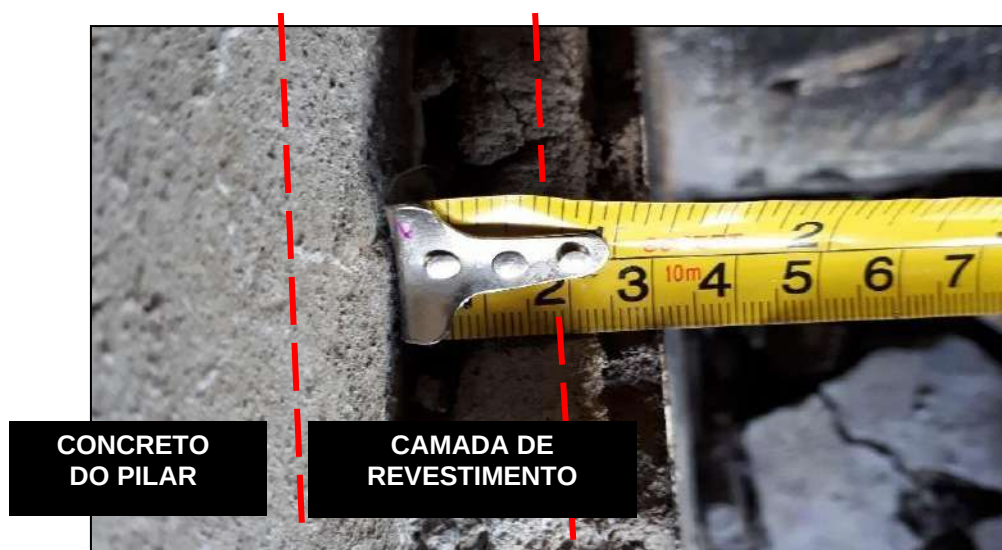
Figura 06: Detalhe da camada de revestimento de argamassa em torno dos pilares.
