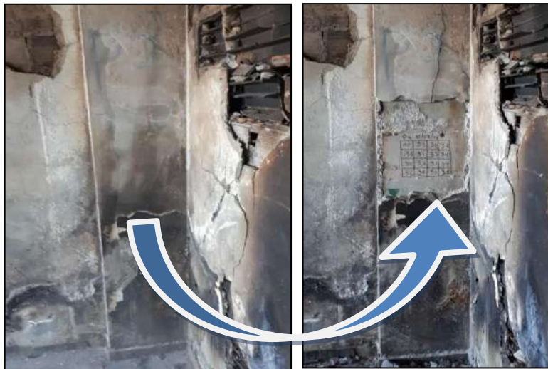
Figura 08: Antes e depois do preparo superficial da estrutura de concreto.
