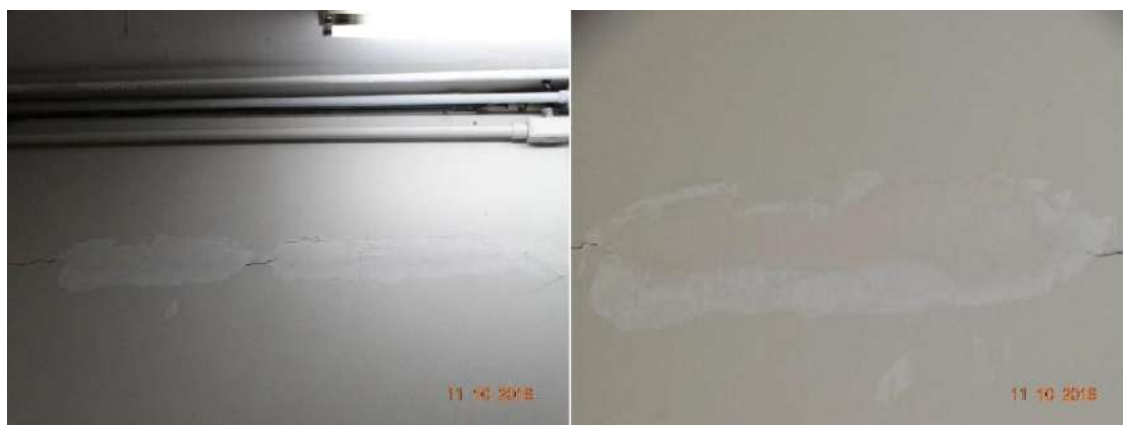
Figura 15 – Monitoramento da rachadura na parede externa do cofre, aparentemente não ativa.
