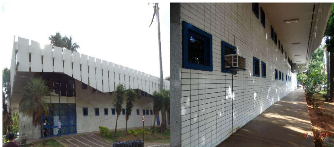
Figura 03 – Revestimento gail nas fachadas leste (esquerda) e oeste (direita).
