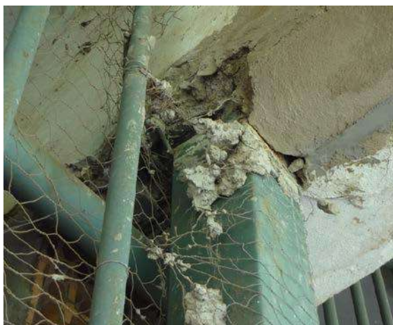
Figura 08 – Ligação de pilar metálico com viga.
