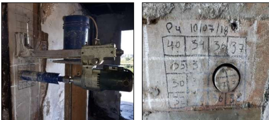
Figura 13: Extração dos testemunhos de concreto.
