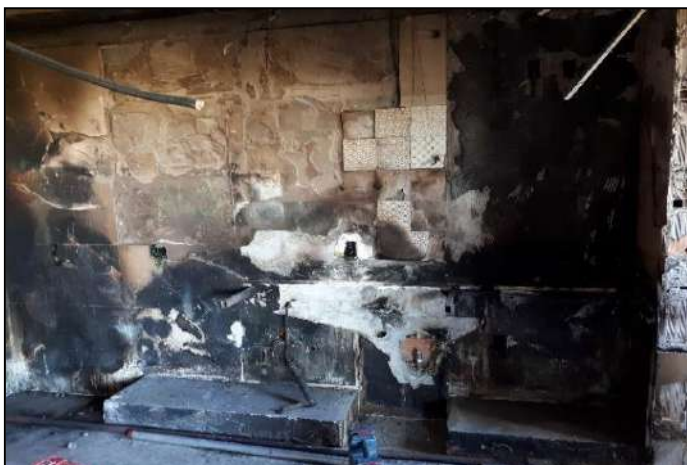
Figura 01: Detalhes da Cozinha.
