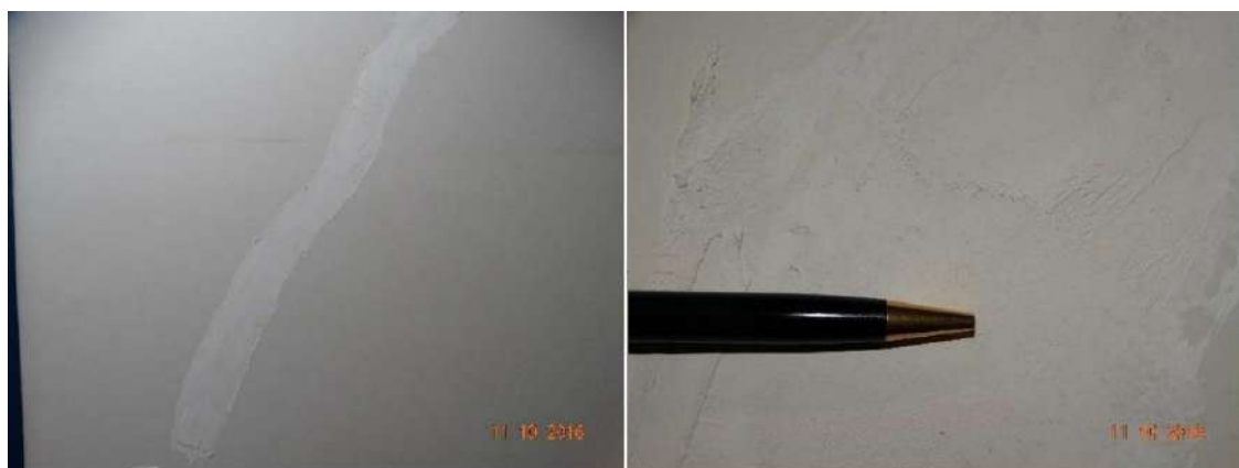
Figura 16 – Monitoramento da trinca na parede externa do cofre, aparentemente não ativa.
