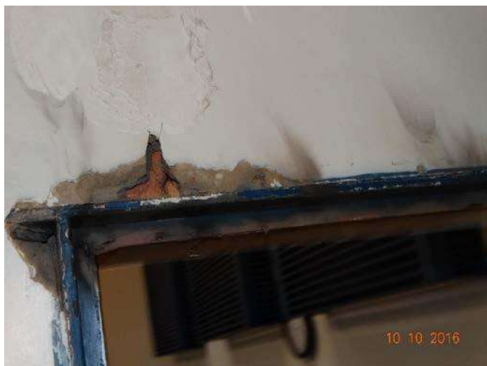
Figura 13 – Porta de entrada ao cofre sem verga.
