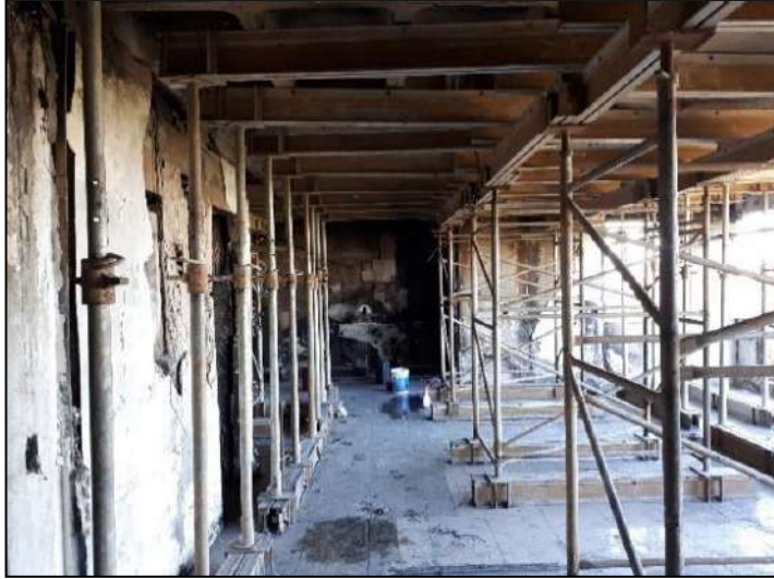
Figura 03: Escoramento metálico.
