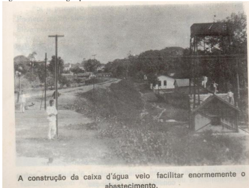
Figura 2– Caixa de água para abastecimento da locomotiva
