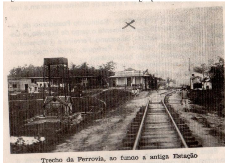
Figura 3 - Trecho da Ferrovia Belém – Bragança em Santa Izabel
