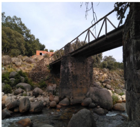
Figura 1. Puente y edificio. (Fotografía O.T)
