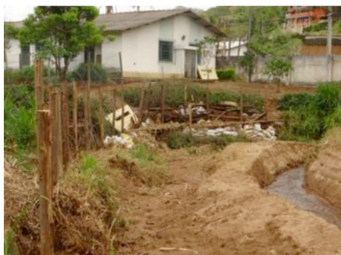
Figura 2: Redirecionamento do córrego.
