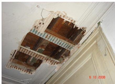
Fig 4 - Tecto estucado degradado (Reaes Pinto)
