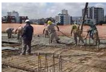
01 CANTEIRO DE OBRA
