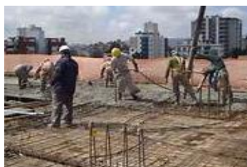
01 CANTEIRO DE OBRA
