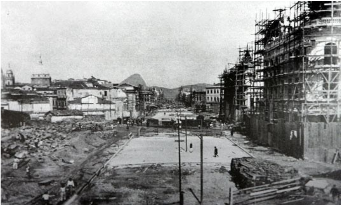
Abertura da Avenida Central: destruição de cortiços e edificações coloniais (esquerda) e construção de novos edifícios (direita). Fotografia de Augusto Malta, 1904.
