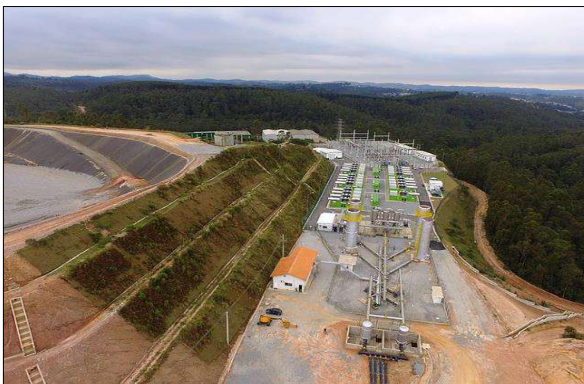
Figura 23 – Unidade de captação de biogás e termelétrica no Aterro Sanitário Caieiras.
