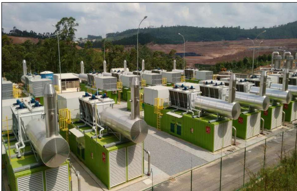
Figura 12 – Conjunto de motogeradores elétricos da termelétrica no Aterro Sanitário Caieiras (SP). Fonte: Acervo pessoal do autor.
