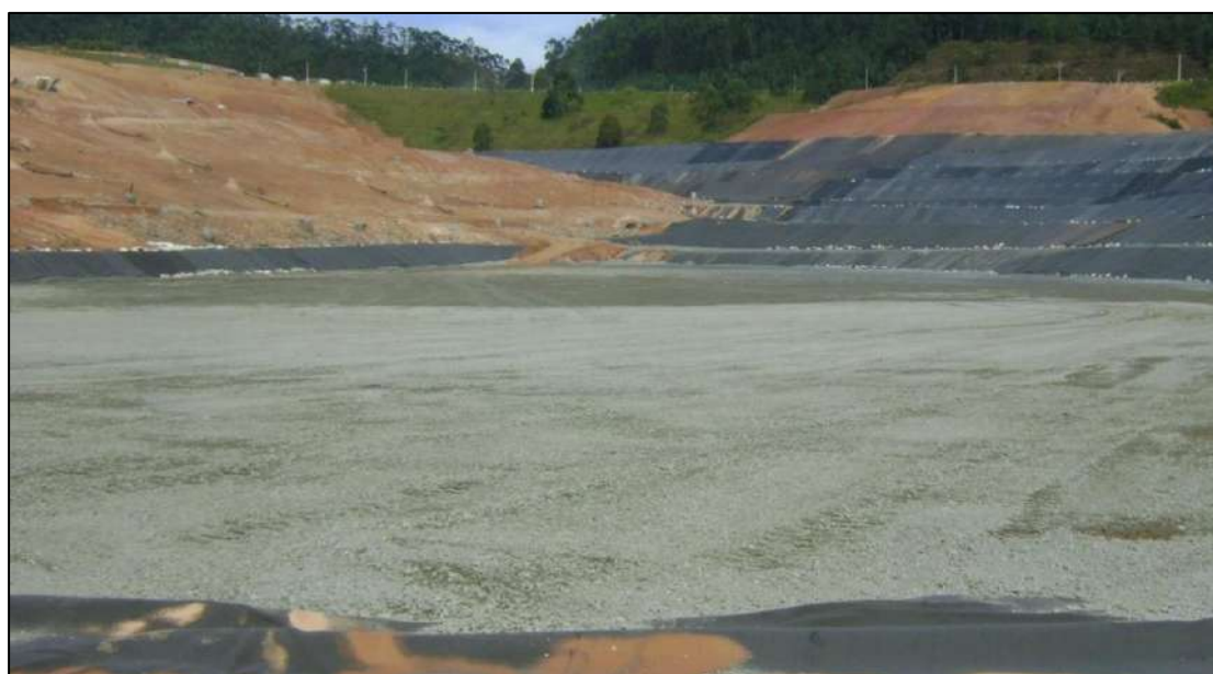
Figura 22 – Construção da base do Aterro Sanitário Caieiras. Fonte: Acervo pessoal do autor.
