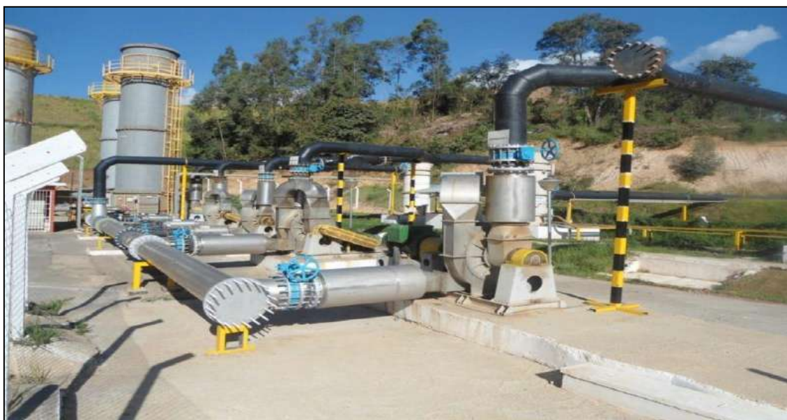
Figura 8 – Exautores para sucção do biogás. Unidade de captação de biogás no Aterro Sanitário Caieiras (SP). Fonte: Acervo pessoal do autor.
