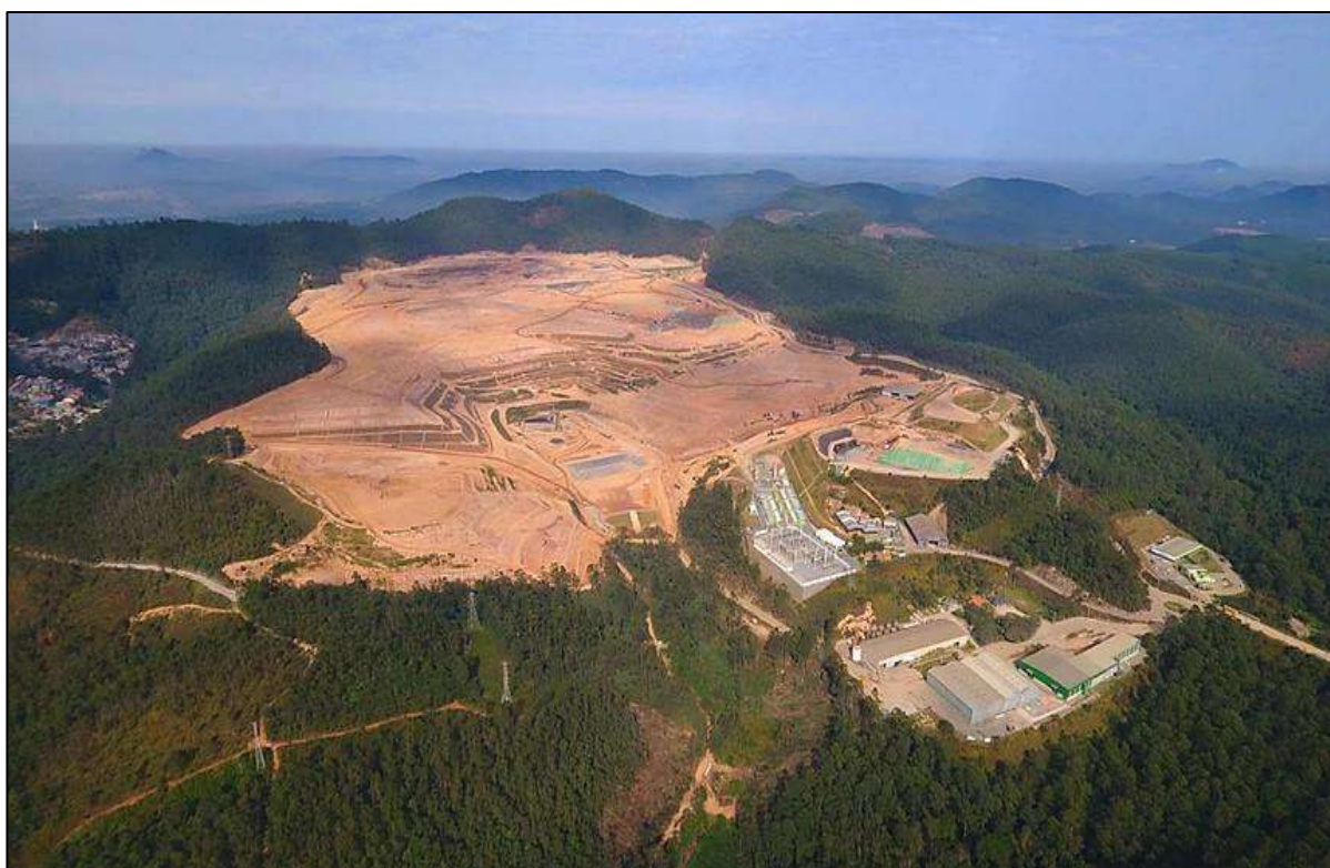
Figura 20 – Aterro Sanitário Caieiras.
