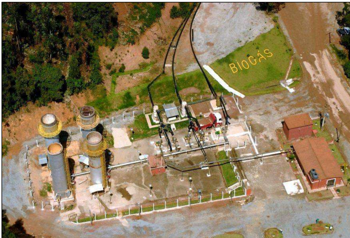
Figura 7 – Sistema de captação de biogás no Aterro Sanitário Caieiras (SP). Fonte: Acervo pessoal do autor.
