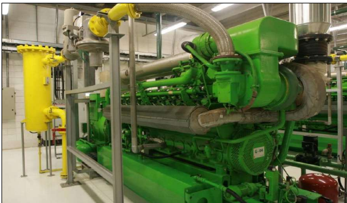
Figura 11 – Motogeradores a biogás para geração de energia elétrica no Aterro Sanitário Salvador (BA). Fonte: Acervo pessoal do autor.
